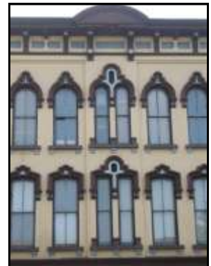
Upper Façade & Cornice
